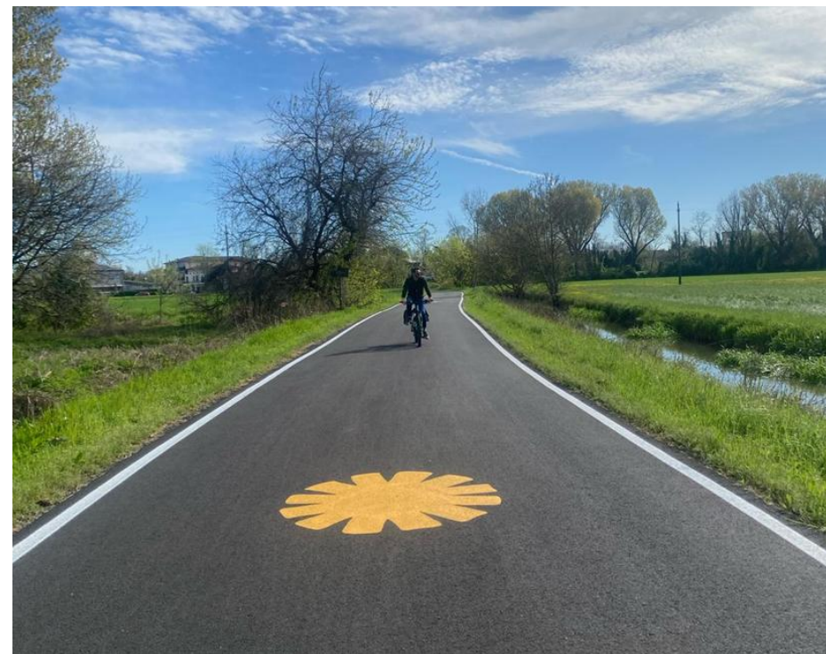
Ciclovía del Sole – lavori completati - 2024
