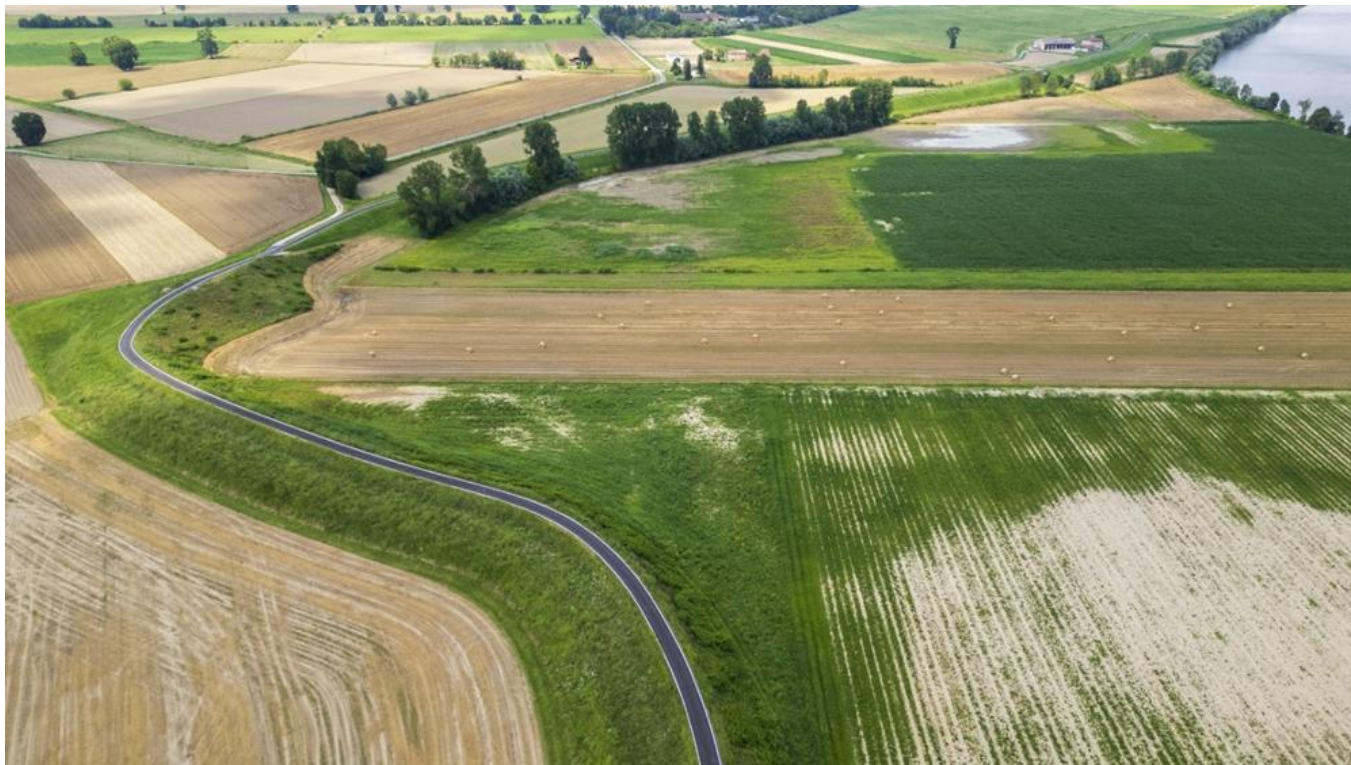
Ciclovia VENTO – lavori in corso di esecuzione
