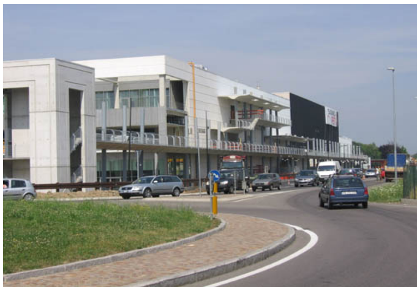
Via della Fornace Cortellezzi .
