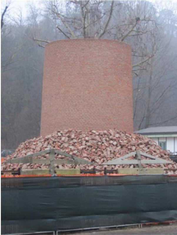
Abbattuta la ciminiera della Mazzucchelli. Un pezzo di archeologia industriale della zona se ne è andato: sono rimasti i resti di una torre che prima **era alta oltre 60 metri** e che oggi non supera l'altezza di una casa, **meno di 20 metri**. La demolizione era iniziata nel 2008, dopo che una perizia **ne aveva dichiarato l'instabilità** e secondo cui i mattoni, che avevano **più di un secolo**, erano ormai deboli e si rischiava il crollo della struttura.
