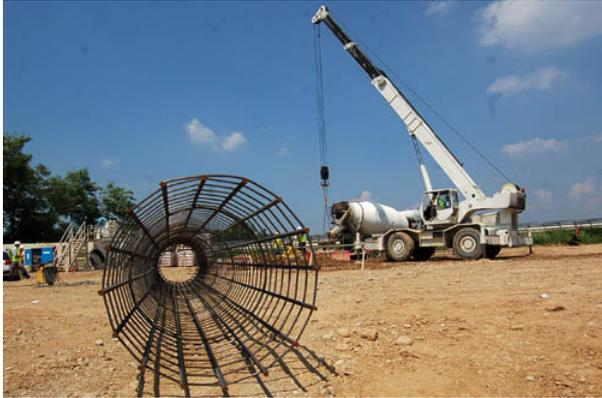
Il cantiere di Cassano Magnago di Pedemontana entra nel vivo con le prime betoniere in azione per la costruzione del **cavalcavia sull'A8** e il primo tratto di strada verso Turate. Nei giorni scorsi, e lo si è potuto vedere passando lungo l'Autolaghi, sono giunti sul lato sud del cantiere di Cassano una trivella, una gru, una macchina per la bentonite e i primi camion betoniera per gettare le fondamenta del cavalcavia, prima vera opera visibile della nuova autostrada.
