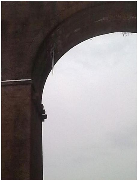
Una grossa e pericolosa stalattite di ghiaccio sul viadotto Olona (a Induno Olona). È visibile proprio sotto il ponte all'altezza dell'intersezione con il ponte ferroviario: pende dalla volta proprio sopra la carreggiata del viadotto.
