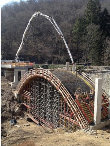
Sono **iniziate le operazioni di getto dell'arcata principale del ponte alla Rasa**. Nelle scorse settimane sono state completate le operazioni di montaggio delle armature costituenti la struttura dell'arco principale, su cui domani sarà appunto **“gettato” il calcestruzzo** con autobetoniere munite di pompe.
