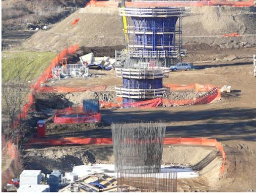
Di fronte allo sbocco lato Svizzera della galleria, sta **il viadotto della Bevera: 430 metri, sette campate da 62 metri**. Nella vallata – oggi segnata dalla striscia di fango del cantiere – **sono in costruzione le sei pile intermedie** che sosterranno il ponte, così come le due “spalle” squadrate, alle estremità: «Quest'estate completeremo l'impalcato» spiega ancora il capocantiere.
