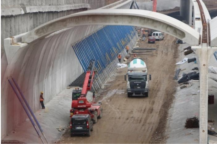
Arriva il “tetto” dei tunnel di Pedemontana. Procedono i lavori a Cislago, dove la nuova superstrada, che collega Bergamo a Malpensa, **passa sotto la Varesina per un lungo tratto**. In questi giorni si stanno posizionando le coperture dei tunnel su entrambi i lati della Varesina, con operai **che lavorano alla posa del calcestruzzo necessario a livellare la copertura**, prima dell’interramento definitivo.
