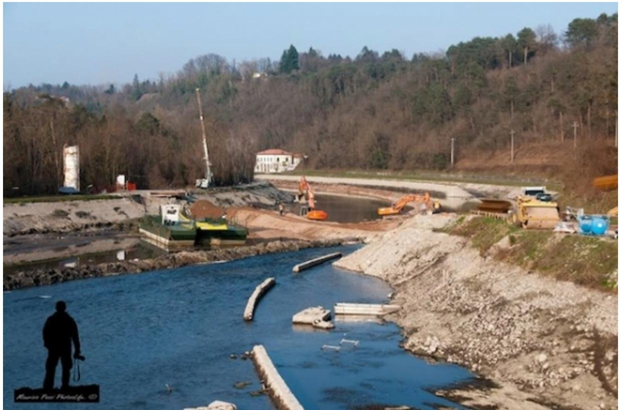
Lo stato dei lavori è che sono già stato realizzate o comunque messe a cantiere le principali opere di messa in sicurezza: consolidamento delle sponde e del fondo del canale, della struttura della diga e delle chiuse per la navigazione. Completata la messa in funzione della chiatta di attraversamento che collega la terraferma all'isolotto posto tra il Ticino e il canale, oggi utilizzato per trasportare mezzi e materiali, con il progetto di convertirlo successivamente per il trasporto turistico.
