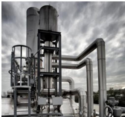
Fra gli interventi di efficientamento energetico merita una citazione la centrale di cogenerazione, realizzata nel 2008 all'interno del polo di **Cassinetta di Biandronno** (Varese). Si tratta di un impianto da 12,5 megawatt di potenza che ha reso autosufficiente da un punto di vista energetico il sito varesino e che ha dato benefici ambientali in termini di mancate emissioni (7mila tonnellate di CO2 e 9 tonnellate di ossido d'azoto) e consumi (60mila metri cubi di acqua risparmiati).
