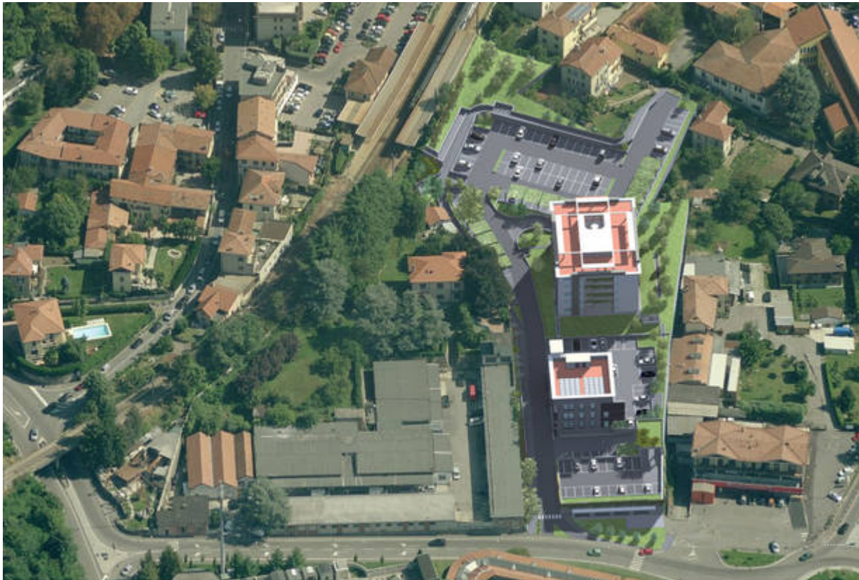
intervento vista ovest
