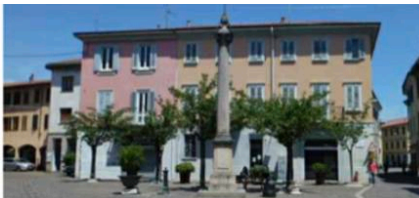
FOTOGRAFIA DA VIA PORTICI - VISTA SUD
