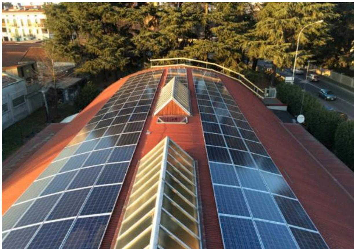
Nel corso del mese di Aprile, Saronno Servizi S.p.A. **ha terminato la realizzazione dell'impianto fotovoltaico presso l'Ex Bocciodromo** di via Piave 1. L'impianto, posizionato sulla copertura dell'edificio, ha una potenza elettrica di 40 kWp in grado di produrre circa 40.000 KWh/anno.
