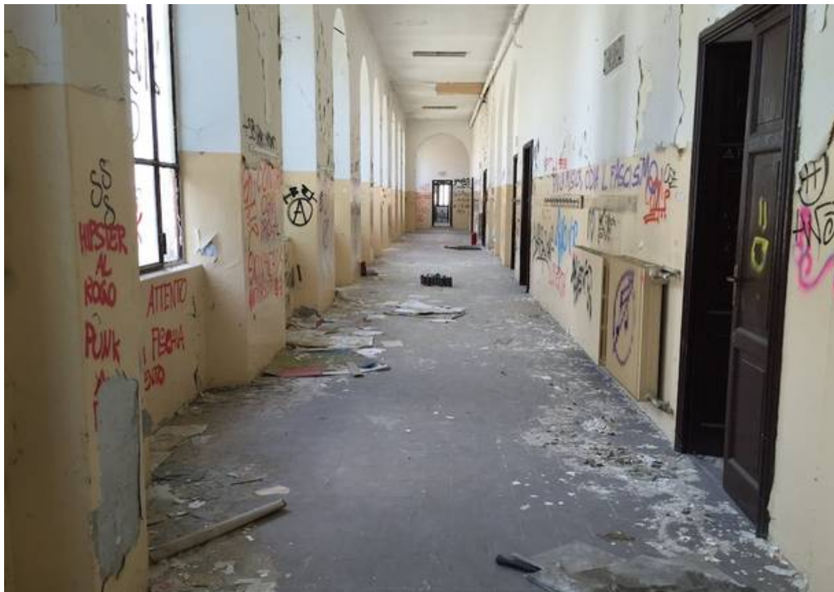
Le condizioni all'interno dell'edificio di via Bottini
