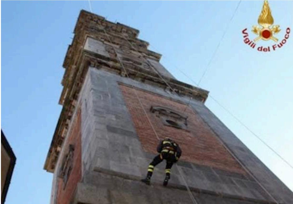
Sono iniziati i lavori per la messa in sicurezza del Bernascone. Sul **campanile di San Vittore** i tecnici preposti stanno realizzando una “mantovana para sassi” in tubi innocenti zincati posizionati a coronamento della struttura del campanile, in prossimità della prima cornice.
