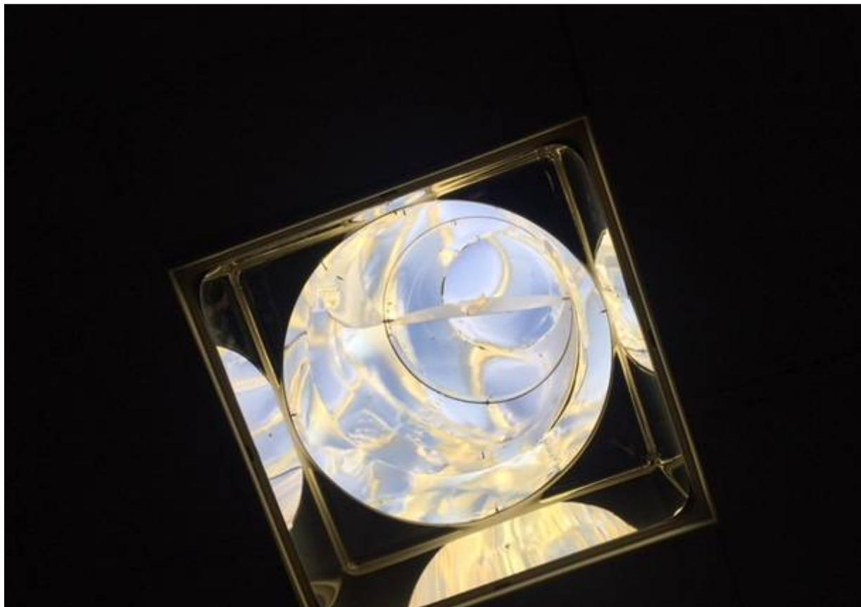
**Questo sistema**, che dà il nome alla ragione sociale – “solarspot” – **incanala la luce solare** da un’apertura sul tetto, o anche dalla facciata di un edificio, e la conduce dopo anche parecchi metri in ogni luogo all’interno di qualunque immobile, dalla casa alla fabbrica o alla stalla, dall’ufficio pubblico al luogo di culto e via dicendo.
