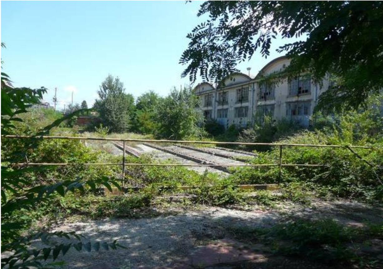
Il “ponte trasbordatore” che serviva a spostare carrozze e locomotive. I capannoni intorno risalgono al dopoguerra e sono stati bonificati nel 2011 dalla presenza di tetti di amianto
