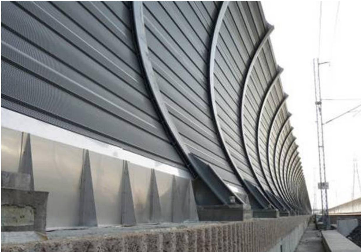
A **Gallarate** arrivano le barriere antirumore lungo la ferrovia. O meglio: i **pannelli fonoassorbenti** – alti fino a sette metri – chiuderanno i **binari della linea del Sempione Domodossola-Gallarate-Milano**.
