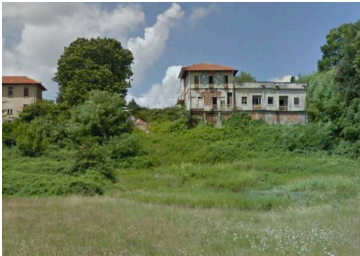
Il grande edificio del “San Pedar” e il pratone sottostante, estate 2015
