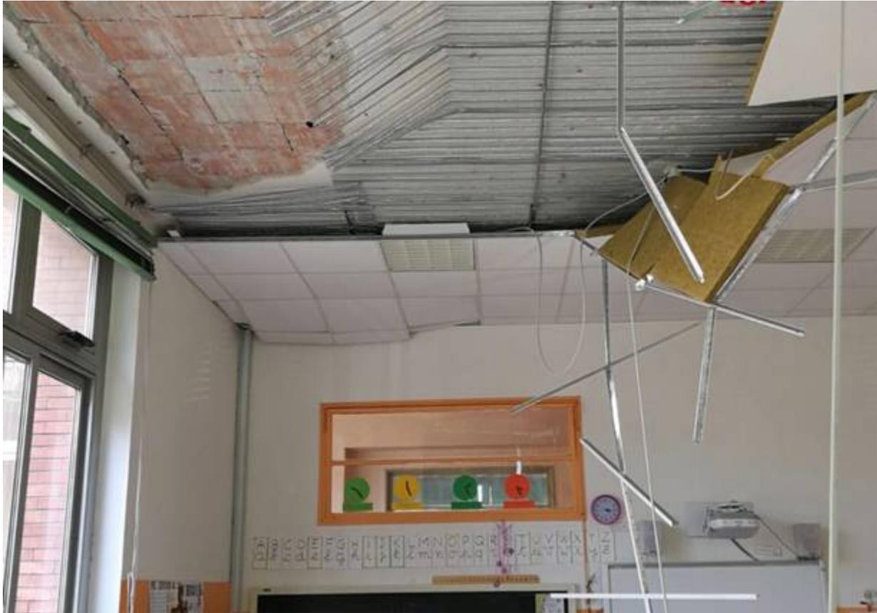
**Il crollo alle scuole Bossi è stato causato**, secondo le prime risultanze delle indagini, da **tasselli troppo corti** che sarebbero stati usati per le reti di protezione posizionate tra i controsoffitti e il soffitto. Proprio quelle **reti di sicurezza**, dunque, sono state la causa del **crollo sulle teste delle tre alunne rimaste ferite** quel 18 aprile.
