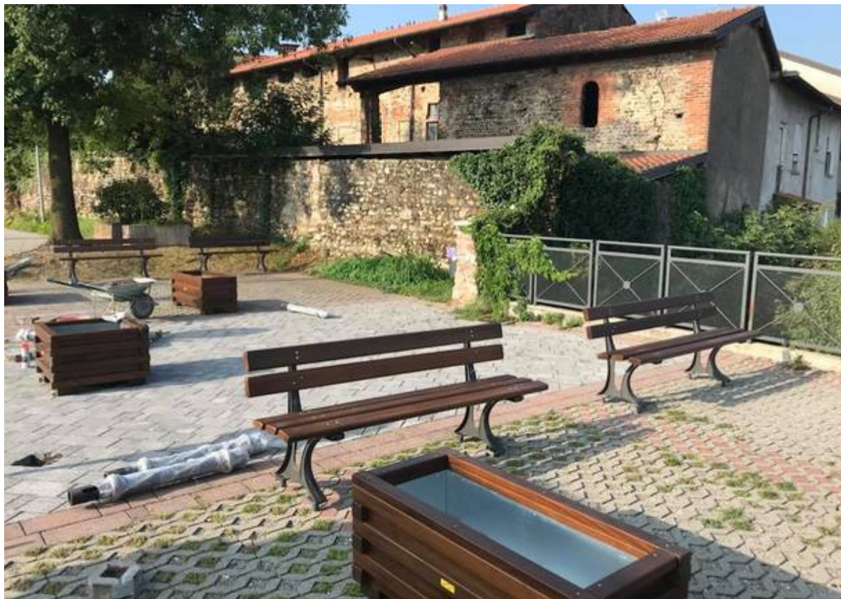
Piazza Santa Maria al Castello a inizio giugno, mentre si completavano gli interventi
