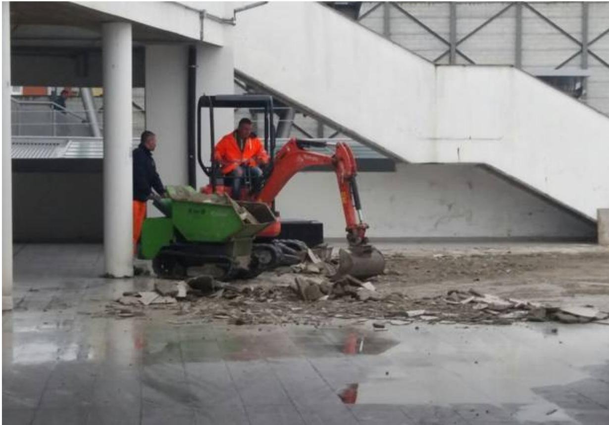
Hanno preso il via ieri, lunedì, i lavori di sistemazione della pavimentazione all'ingresso della **stazione FNM di via Morelli a Castellanza**. L'intervento, che prevede la **rimozione e la sostituzione delle lastre della pavimentazione dell'area di ingresso alla stazione**, è effettuato da Ferrovie Nord.
