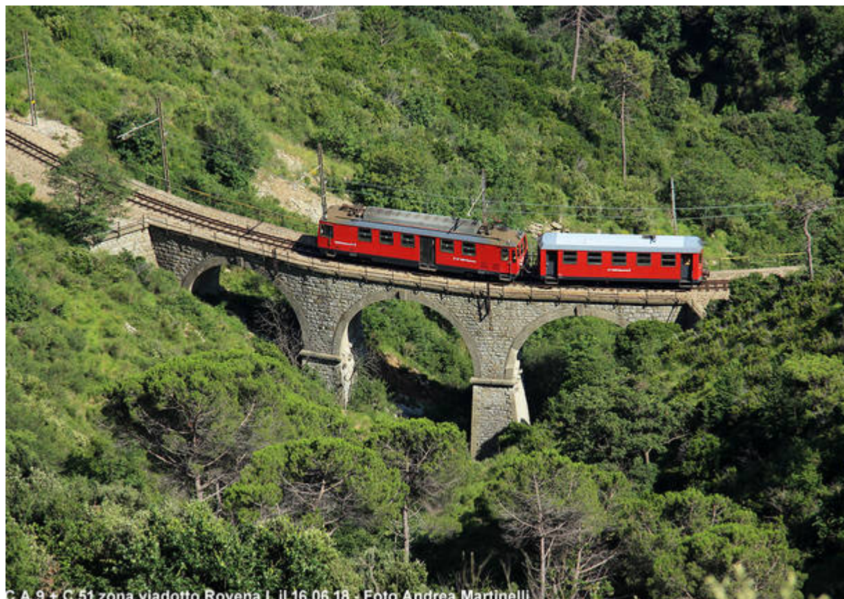
C.A. 9 + C.51 zona viadotto Rovena I, il 16.06.18 - Foto Andrea Martinelli
