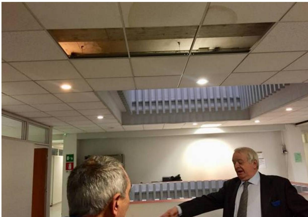
Durante l'ispezione: molti i controsoffitti "saltati" a causa delle infiltrazioni
