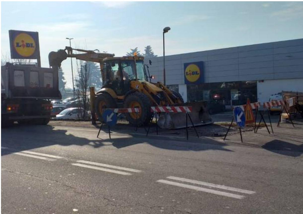
Sono iniziati i lavori di **completamento della rotonda** tra via Battisti e via Carducci. La prima parte dei lavori che prevede la sostituzione dei guard rail di plastica con i definitivi cordoli stradali si concluderà a fine febbraio.
