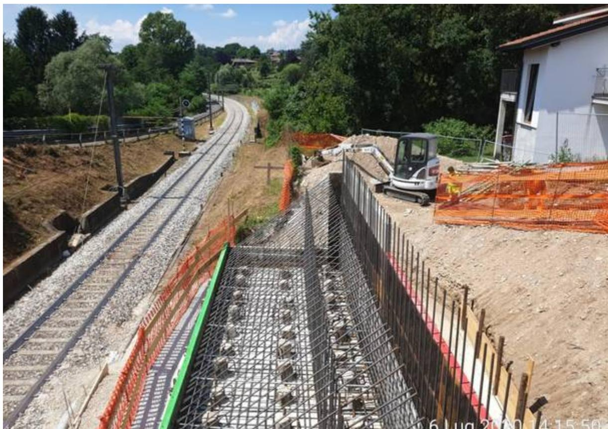
**Entrano nel vivo le operazioni di costruzione del nuovo ponte in via Giordani a Varese.** Stanno per essere ultimati i lavori per la posa del **primo plinto di appoggio** della nuova volta. **Ottanta i metri cubi di calcestruzzo** utilizzati per dar vita alla struttura, posta sulla spalla di monte dell'area. L'ultimazione delle procedure è prevista nel pomeriggio di oggi, venerdì 10 luglio.
