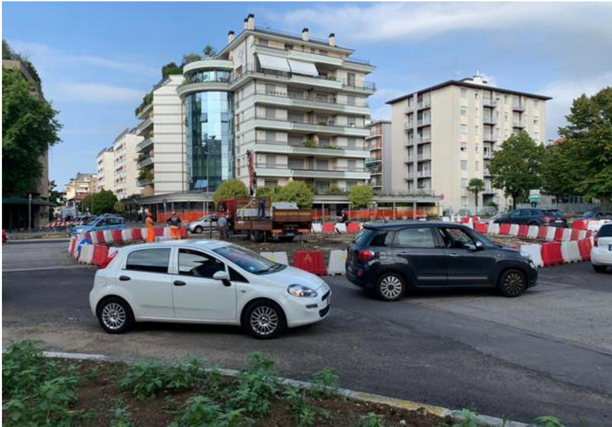
Avanzano i lavori per la realizzazione della rotonda sul viale Diaz, all'altezza di largo Giardino proprio davanti alla Procura di Busto Arsizio. L'impresa ha realizzato i marciapiedi e i cordoli laterali e ora si sta concentrando sull'elemento centrale della rotatoria, infine si passerà all'asfaltatura.
