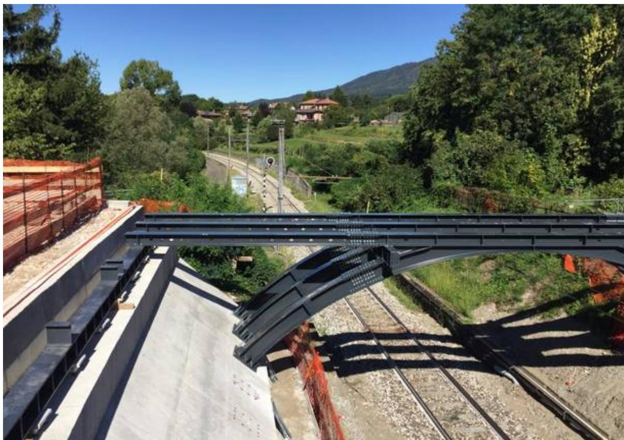
**È iniziata la scorsa notte la fase conclusiva dei lavori del ponte di via Giordani.** Con la posa delle travi portanti che sosterranno la volta del nuovo ponte più ampio e sicuro, inizia a delinearsi la nuova struttura dopo 9 mesi di chiusura del tratto che **collega Masnago con la Valle Luna.**
