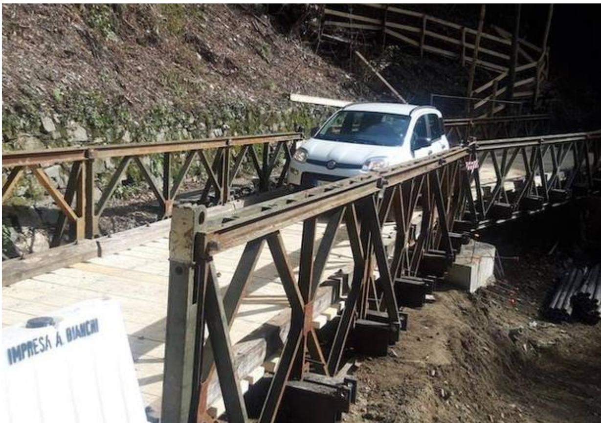
**Il transito è consentito ad un solo veicolo per volta e a senso unico alternato** a mezzi con limite di massa complessiva a pieno carico pari a **10 tonnellate** e limite di sagoma in larghezza massima non eccedente i due metri. Nell’attraversare il ponte sarà inoltre vietato effettuare brusche accelerazioni e/o frenate, superare il limite di velocità (10 km/h), sostare e fermarsi sullo stesso.
