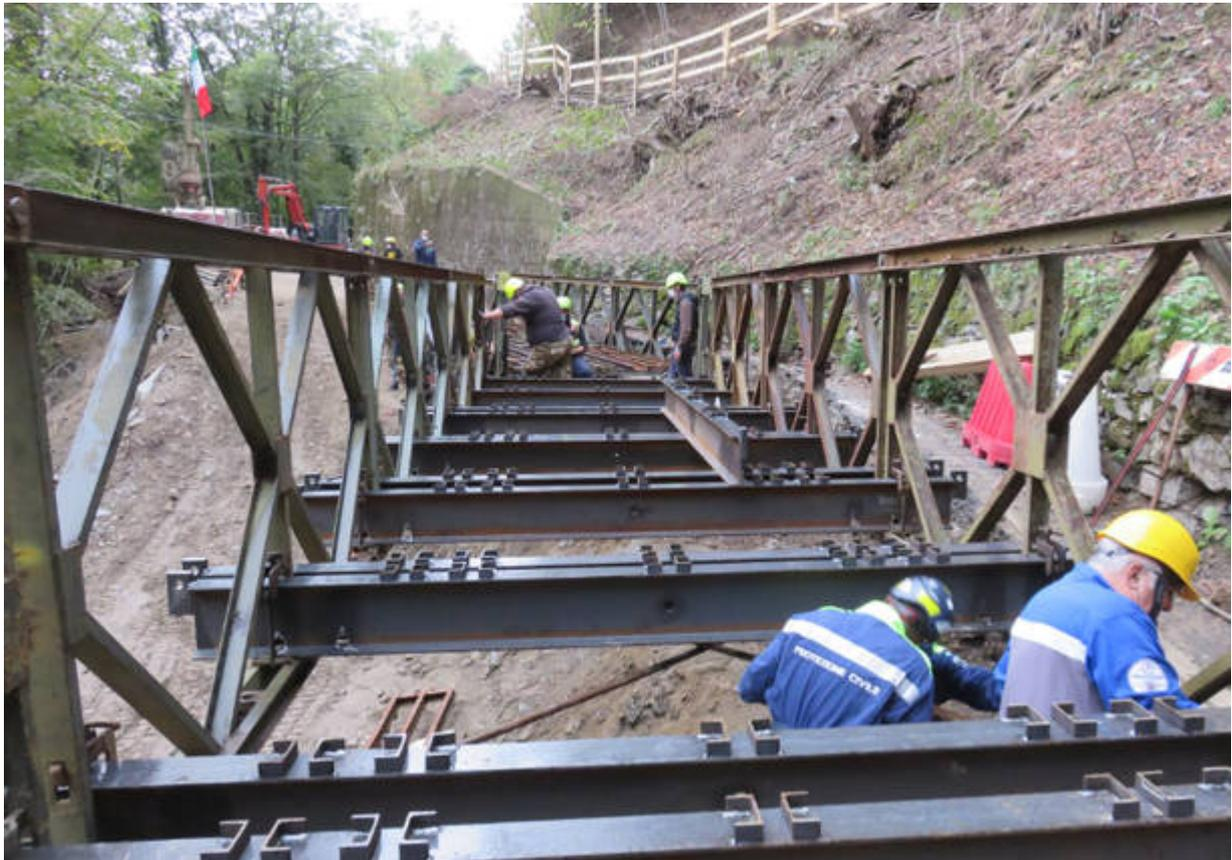
**Nel fine settimana è stato portato a termine il posizionamento del ponte Bailey che consente il ripristino del collegamento stradale lungo la S.P. 6 con il Comune di Curiglia con Monteviasco. Ieri si sono concluse le operazioni di collaudo, mentre oggi i tecnici del settore viabilità sono stati impegnati con la sistemazione delle rampe di accesso al ponte e con la realizzazione di alcune opere accessorie al transito in sicurezza.**
