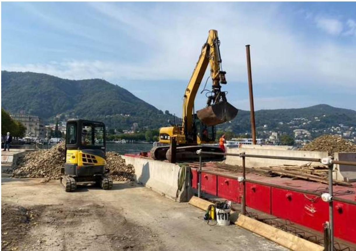
Procede, presso il **cantiere delle paratie di Como**, l'attività di realizzazione dei pali di fondazione della vasca 'A'. I pali sono in avanzamento da Sant'Agostino verso piazza Cavour, quindi per proseguire con la loro realizzazione, va garantita la demolizione della piattaforma.
