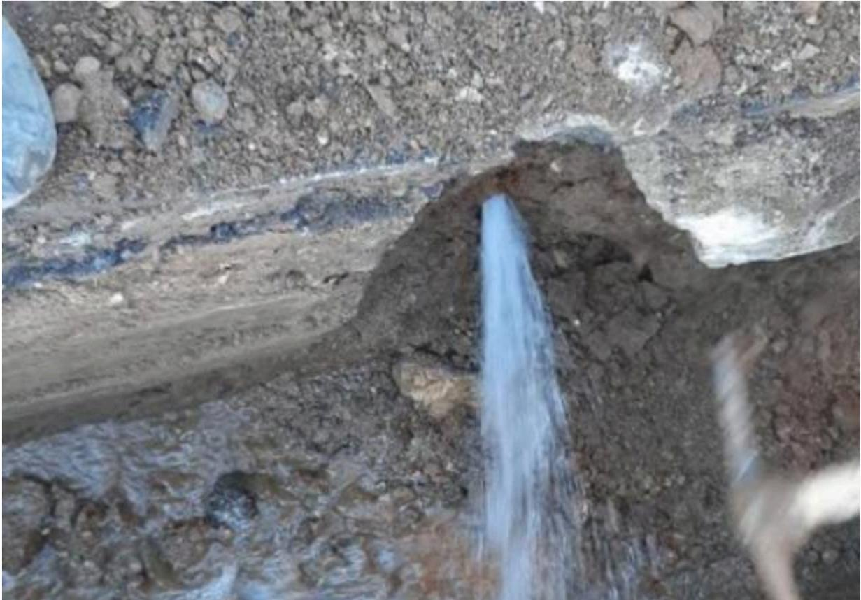
E' stato già avviato e andrà a compimento alla fine di febbraio un progetto pilota per la **ricerca di perdite nella rete idrica degli acquedotti comunali in provincia di Varese**. Il progetto è di Alfa Srl, gestore unico del servizio idrico integrato in provincia di Varese ed è svolto in collaborazione con 2f Water Venture. La tecnologia utilizzata è davvero innovativa: **i “buchi” nelle tubazioni, infatti, saranno trovati da un satellite che viaggia a 637 chilometri dalla Terra**.
