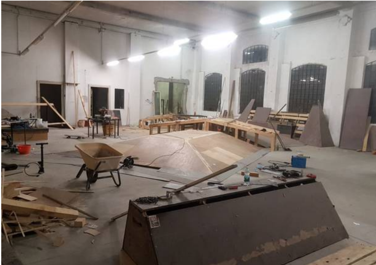
I lavori nella nuova sede di via Fanti
