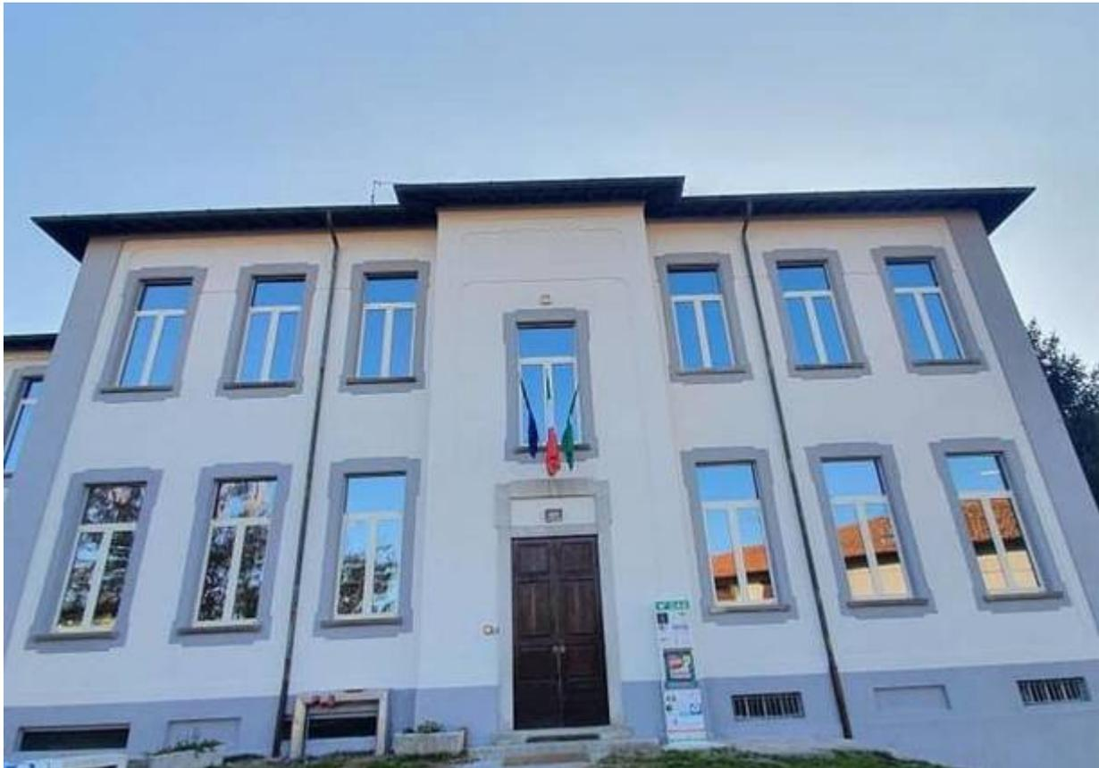
Rifacimento della facciata e sostituzione di tutti i serramenti per garantire un efficientamento termico: la scuola secondaria di primo grado “Alessandro Manzoni” di **Besnate** si rinnova, ma senza tradire l’antico aspetto.
