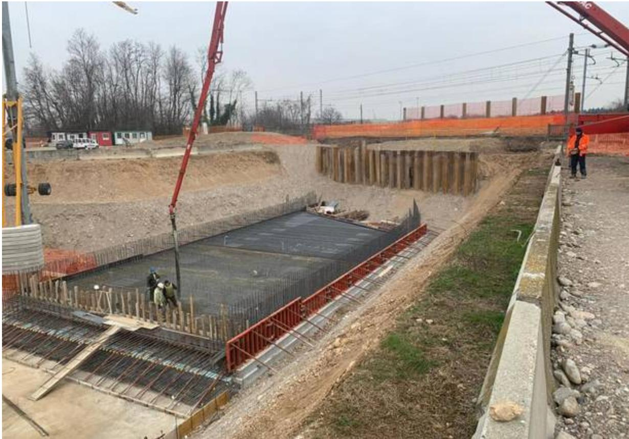
Dopo le opere preparatorie delle aree interessate dal nuovo **collegamento viabilistico di Sant'Anna con il Sempione**, stanno entrando nel vivo i lavori di realizzazione del sottopasso ferroviario alla linea Rho-Gallarate funzionale al collegamento viario tra la strada S.S.33 la via per Cassano Magnago.
