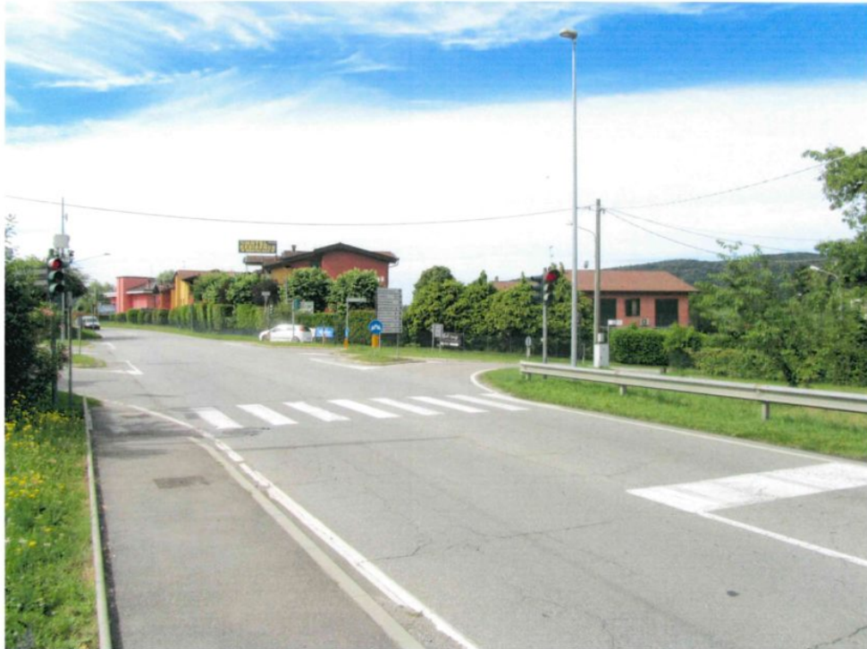
L'incrocio di via Milano a Ternate col semaforo prima dei lavori
