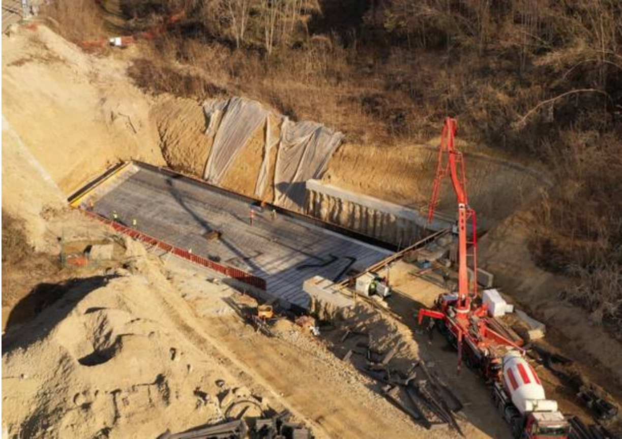
La preparazione della terza “scatola” per l’ultimo sottopasso
