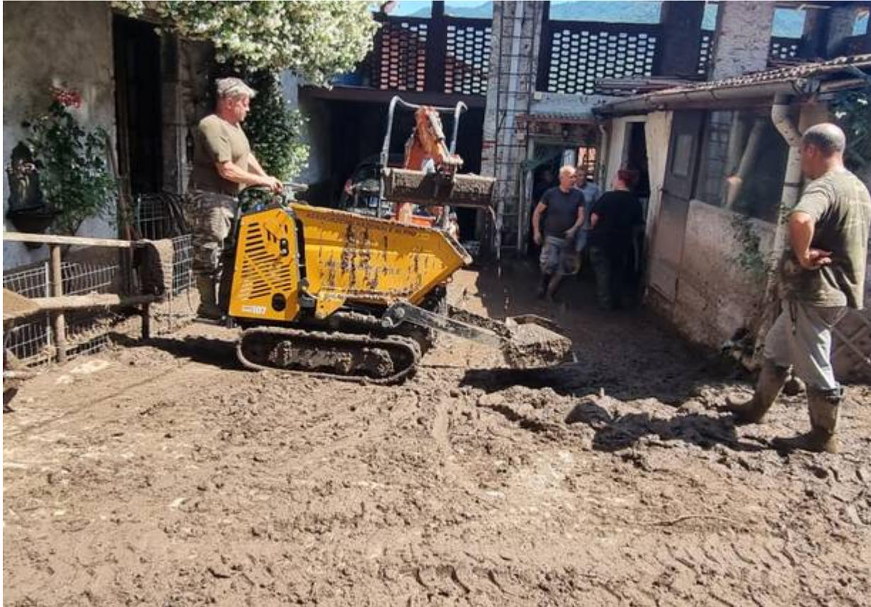
Dopo una pioggia di **70 millimetri** durata solo **25 minuti**, una **massa di rocce di oltre 2.000 mc** ha **completamente ostruito il ponte di via Sanda**, determinando l’alterazione del corso del torrente Camposanto sul versante di Monte Nudo e provocando una deviazione incanalandosi lungo la via Libertà (quella che passa davanti al Municipio).
