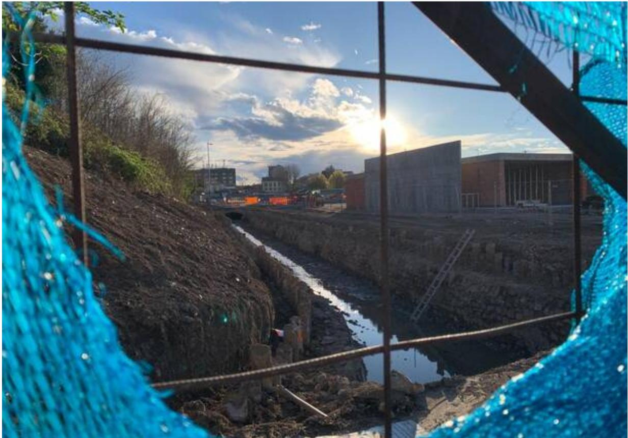
Non durerà ancora a lungo l’insolita vista che si può sbirciare in questi giorni attraverso le reti di protezione del cantiere di piazzale Kennedy a Varese: l’acqua del torrente Vellone che “splende” al sole durante i lavori di ristrutturazione della sua copertura, **parzialmente crollata in quel punto a luglio del 2018**. Per ricostituirla è stato necessario scoperchiarla. Inoltre, in questi giorni un po’ più piovosi il letto del torrente si è un po’ gonfiato: il risultato è stato questa foto.
