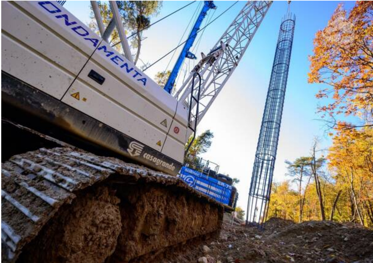
Il cantiere a novembre 2023 (foto SALC)
