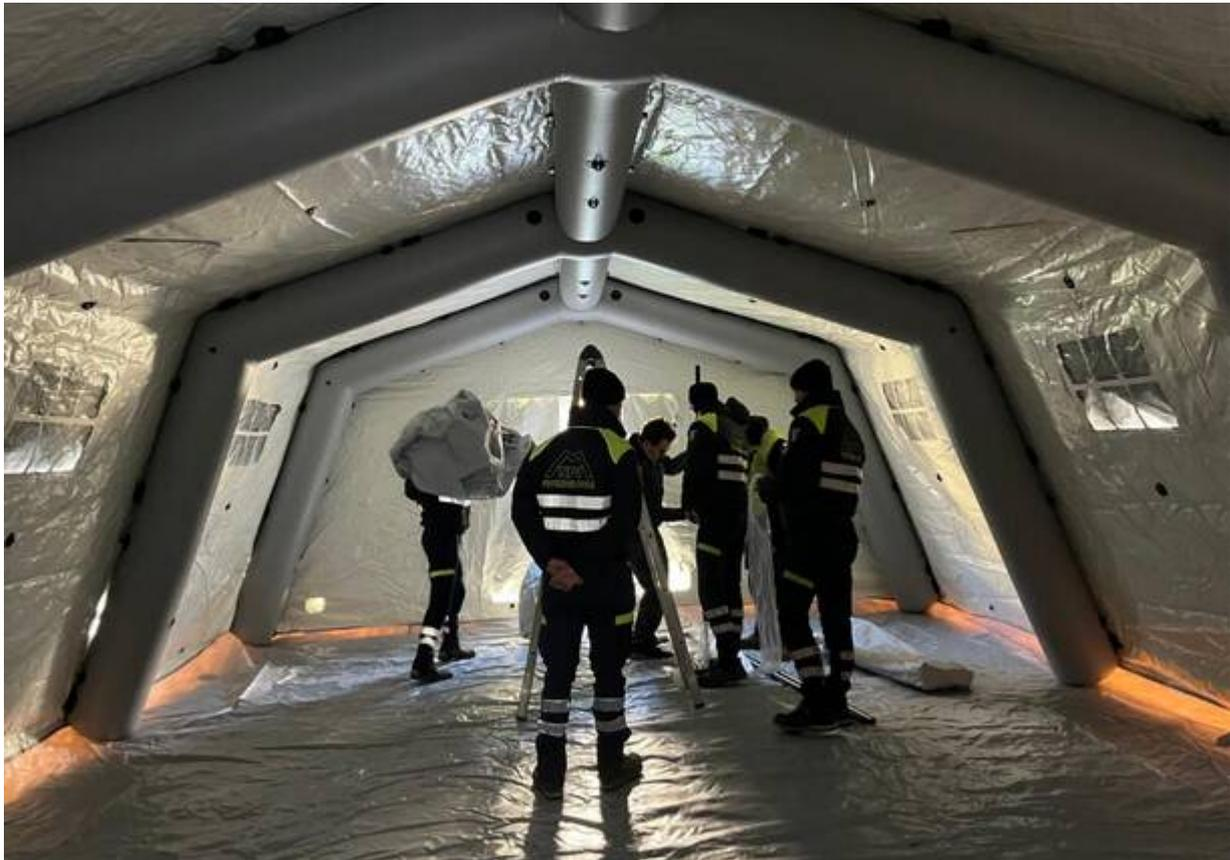
**La Protezione Civile del Comune di Varese potenzia la dotazione delle attrezzature per la gestione delle emergenze e delle attività di soccorso.** E' stata acquisita grazie al finanziamento regionale una nuova tenda pneumatica a montaggio rapido: si tratta una struttura gonfiabile, con **una superficie di circa 50 metri quadri**, che **può essere montata in pochi minuti** per la creazione di dormitori, strutture sanitarie provvisorie, ambienti di ricovero o stoccaggio.
