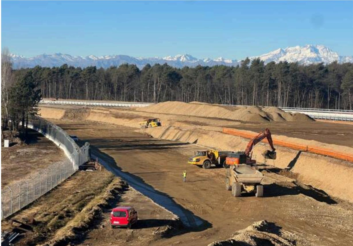
**Proseguono, anche nel cuore dell'inverno, le operazioni di cantiere della ferrovia Gallarate-Malpensa Terminal 2:** sono in corso in questo periodo, ad esempio, gli scavi della **galleria artificiale Ga05**, a ridosso della superstrada 336, in territorio di Somma Lombardo.
