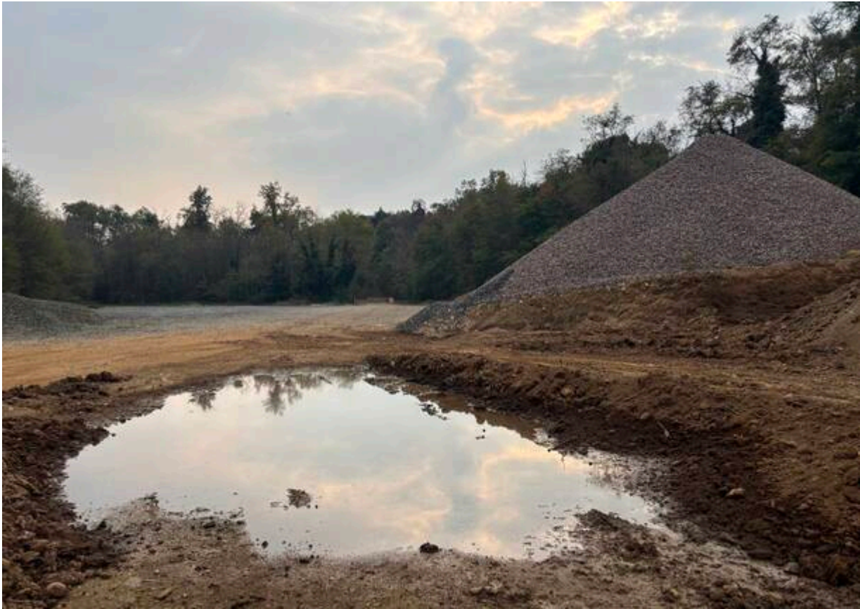
Aree di cantiere della ferrovia Gallarate Malpensa, Quartiere Ronchi
