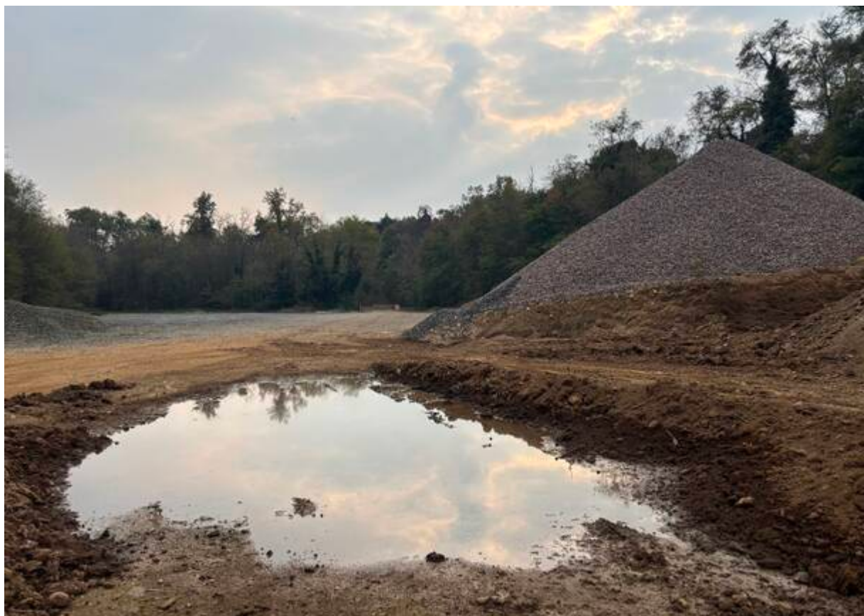
Cantiere della ferrovia Gallarate-Malpensa
